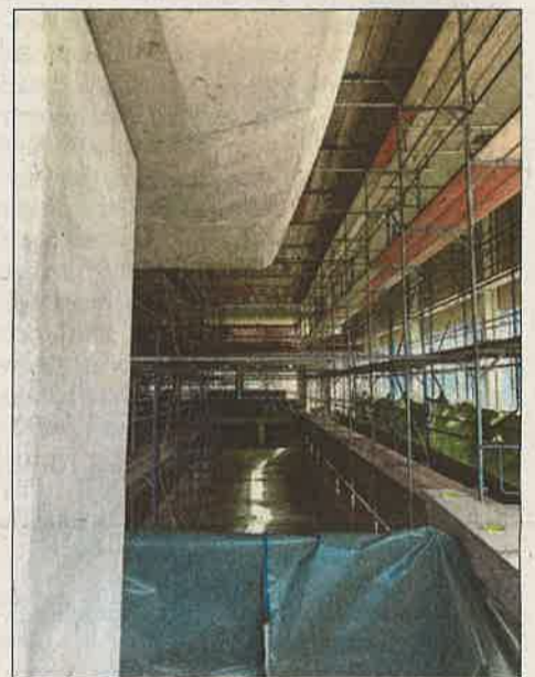
Das künftige 25-Meter-Becken
